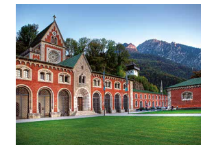
Alte Saline Bad Reichenhall
